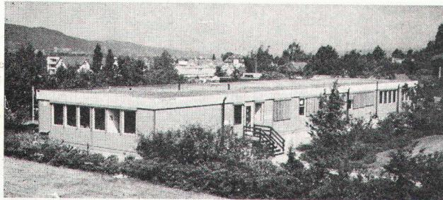
Holzelementkonstruktion, demontierbar, Fensterelemente mit Doppelverglasung und Raff-Lamellen-Storen, inklusive elektrische Installationen (Beleuchtung, Heizung, Klimageräte) sowie sanitäre Einrichtungen (WC-Anlagen, Spültsche, 200-Liter-Boiler).
