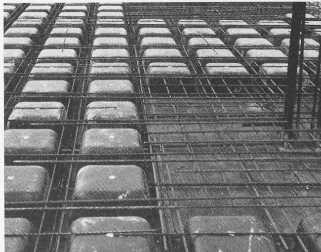
Bilder 10 und 11. Wiedergewinnbare Kassettendecken-Schalkörper aus Kunststoff bei der Montage
