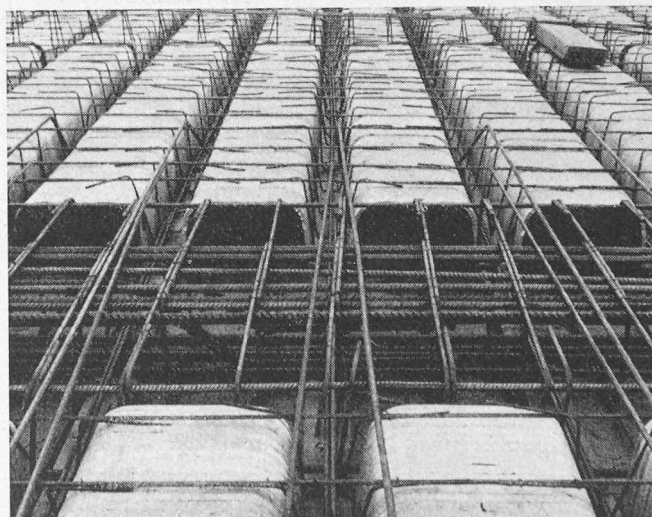
Bilder 7 und 8 unten. Verlorene Schalung in Stahlblechausführung
