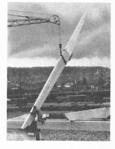
Bild 2 (rechts). Teil eines Gerberträgers mit Kragarm. Querschnitte nach den Momenten abgestuft. Hersteller: W. Zöllig AG, Arbon
