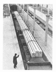
Bild I (links). Gerader Träger als Zwillingsträger ausgebildet, Länge 40 m, über 6 Felder durchlaufend, Bahntransport. Hersteller: W. Zöllig AG, Arbon
