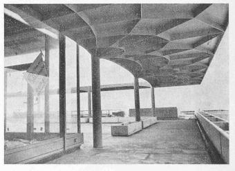
Optimierung beim Entwurf von Raumfachwerken aus Stahl» eingehend untersucht.) Da beim Dreieckrost sechs, statt nur vier Träger wie beim Rechteckrost an eine Stütze anschliessen, ist er in dieser Beziehung günstiger.
