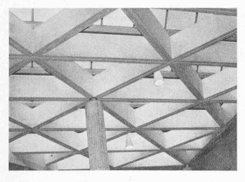
Bild 9. Kragplatte am Dachaufbau. Entwurf Prof. Hauri, Ausführung Fa. Nyffenegger, Stahlbau, Zürich
