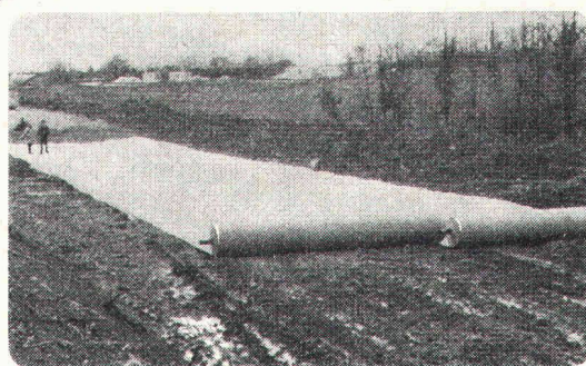
Abrollen der Matte, Vorkopf- aufschüttung
