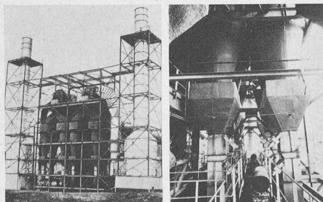
Die Rohdichte der Schaumschicht wurde mit 40 kg/m³ gefordert. Wegen der ungünstigen Jahreszeit, es wurden Tiefsttemperaturen von -28 °C gemessen, wurde die gesamte Trocknungsanlage winterfest umkleidet und beheizt. Insgesamt wurden 900 m² mit Sprüh Schaum isoliert.
