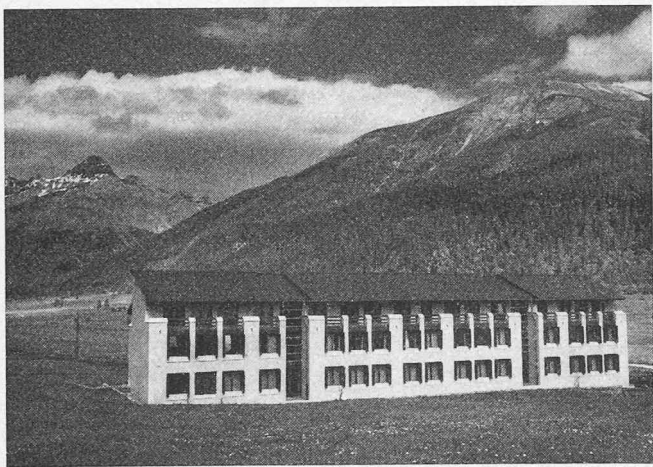
Südwestansicht des Schlaftraktes, 2. Obergeschoss: Heimleiterwohnung und Personalzimmer
