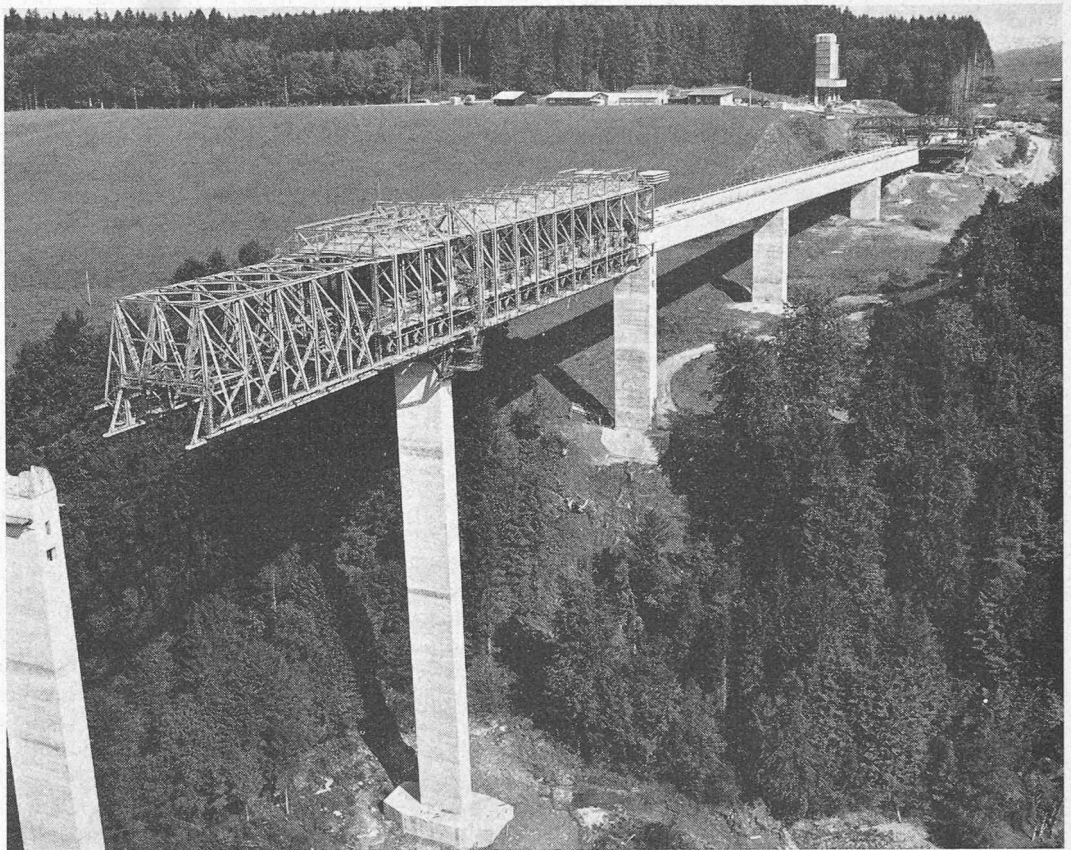
Bild 14. Übersicht über die Baustelle. Im Hintergrund sieht man das «Flügelgerüst» für die Verbreiterung der Brücke
