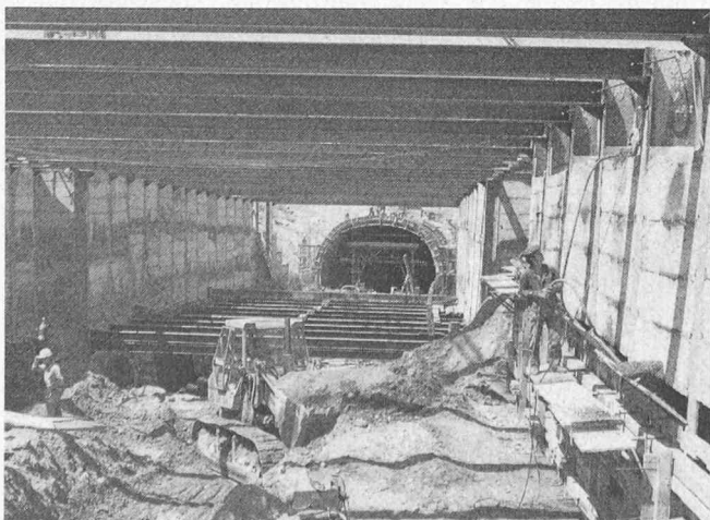
Bild 6. Los 5: Spriessung und Aushub
