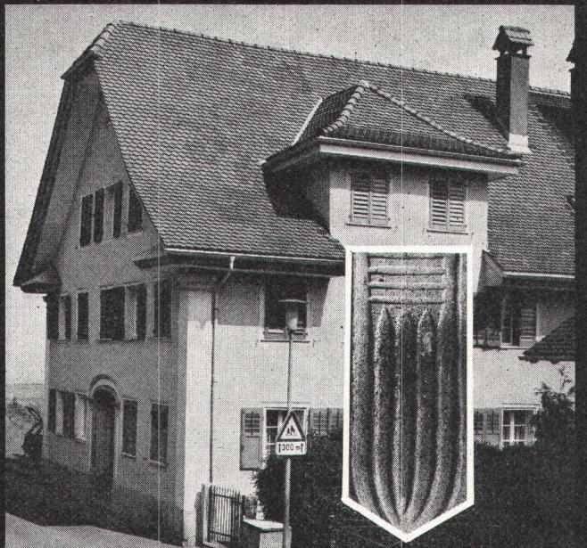
Der «Biber alt» ist ein rustikaler Tondachziegel, der in allen Teilen der Spitzenqualität moderner Ziegel entspricht, aber in Form und Farbe dem früheren Handziegel gleicht. So hat er beispielsweise eine «handgestrichene» Oberfläche und erhält vor dem Brennen seine unregelmässige Farbe. Dieser Ziegel eignet sich speziell für die stilgerechte Restaurierung erhaltenswerter Gebäude.
