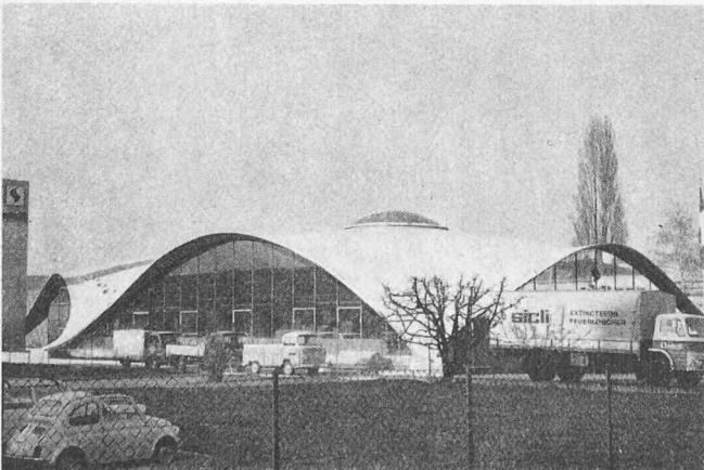
Bild 5. Oberlicht von 8 m lichtem Durchmesser, bestehend aus acht Segmenten
