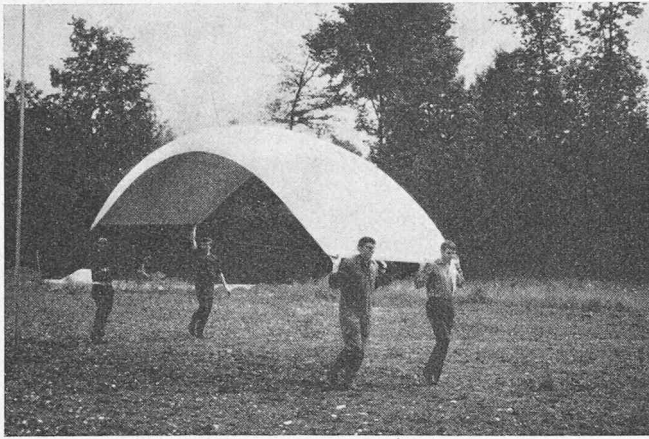
Bild 7. Element von 6 m Spannweite und 1,5 mm Schichtdicke
