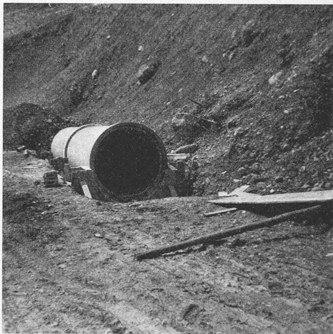
Bild 6. Feldversuch, Ansicht vor Einfüllen
