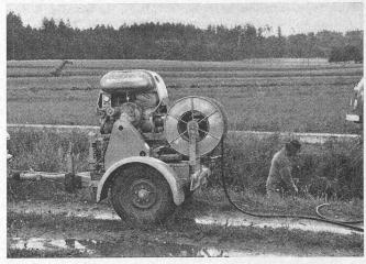
Bild 8. Spülung eines Dränsaugers von der Grabenausmündung her mit «Hydromat-Hochdruckreinigungsgerät Birchmeier Titan-BH-III». Wasserentnahme (rd. 701 min) aus dem Vorfluter oder Zufuhr mit Druckfässern [13], [14]
