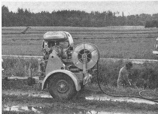
Bild 8. Spülung eines Dränsaugers von der Grabenausmündung her mit «Hydromat-Hochdruckreinigungsgerät Birchmeier Titan-BH-III». Wasserentnahme (rd. 70 l/min) aus dem Vorfluter oder Zufuhr mit Druckfässern [13], [14]
