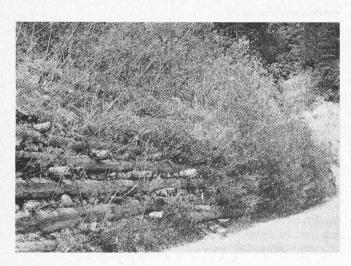
Bild 3. Sanierung einer hohen Abrutschung durch Einbau eines Hangrostes aus Holz, Abstützung nach unten, Verankerung nach hinten, danach Auffüllung und Begrünung
