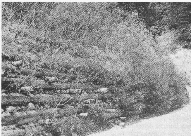
Bild 2. Holz-Grünschwelle, 10 Jahre alt, durch Einlage von Weiden-ästen bleibt sie nach Vermorschen des Holzes funktionsfähig
