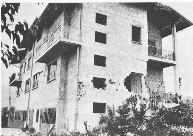
Bild 11 (nach dem 15. Sept.). Rechts: Wohnhaus mit Werkstatt bei Arterga nach erneuter Bebenbeanspruchung. Infolge der weiteren Bebenbelastung stürzte die Stirnwand im Mittelgeschoss ein. Die Tür- und Fensterpfosten der Längswände wurden zermalmt und brachen teilweise ein. Die Schubfestigkeit dieser Betonhohlsteinwände war gering, da der Mörtel in den Lagerfugen keine Verzahnung der übereinanderliegenden Schichten bewirkte
