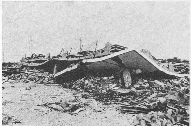
Bild 12 (nach dem 6. Mai). Links: Wohnhaus mit Verkaufslokal bei Artegna. Stahlbetonskelettbau mit Backsteinfüllwänden in den zwei Obergeschossen, im dreiseitig offenen Erdgeschoss sind nur die hintere Längswand und das Treppenhaus ausgefacht. Die Zerstörungen sind auf das Erdgeschoss konzentriert, in dem eine Drehbewegung um den Treppenhauskern mit rund 40 cm Maximalverschiebung auftrat. Die Backsteinwände des Treppenhauses wurden stark zerstört, diejenigen des Obergeschosses blieben unbeschädigt
