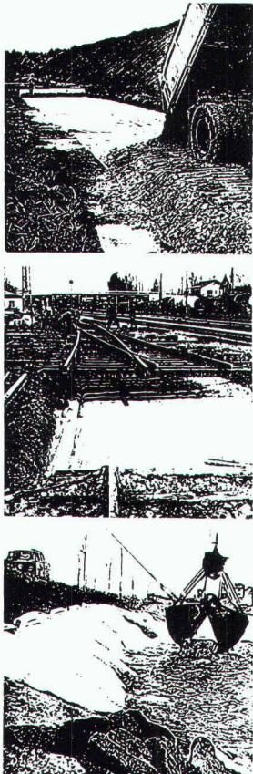
Polyfelt TS spart Zeit, Kosten und Schüttmaterial und hilft besser, billiger und schneller zu bauen. Polyfelt TS – Trenn- und Filterschicht zwischen schlammigem Boden und Kiesdrainage oder Schüttung, im Straßenbau, im Bahnbau, im Wasserbau, bei der Anlage von Sportplätzen, Lagerplätzen oder Grünflächen auf Dachterrassen.
