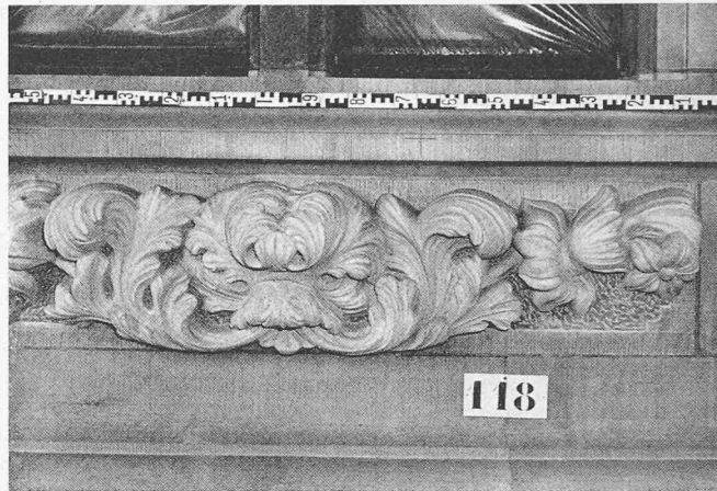
Das restaurierte Ornament, Sandstein
