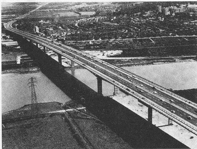
Die Brücke hat über dem Fluss eine Spannweite von 174 m, die anschliessenden 113 m langen Endteile bestehen aus doppelt geschweissten Stahlkasten-trägern mit geschweisstem Stahldeck. Nach Ansicht der Preisrichter «verwertet die Konstruktion die Festigkeit, Leichtigkeit und Vielseitigkeit von Stahl im höchsten Masse, und die gut ausgeglichenen Proportionen des Unter- und Oberbaus bedingen ein wirtschaftliches und ästhetisch ansprechendes Ergebnis».
