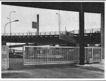
Beispiel eines freiaustragenden Arealtores mit Antrieb metoran
