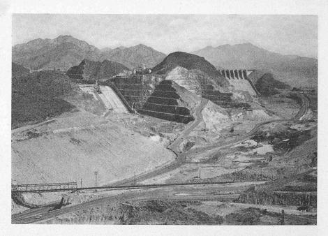
Im Sommer 1974, als das Seebecken bis zum Überlauf hätte aufgestaut werden sollen, ging praktisch das ganze Stauvolumen durch Erosionsschäden an den Umleitungstunneln 1 und 2 verloren. Ein Hilfsprogramm zur Behebung der Schäden konnte vor dem Einsetzen der Hochwasserperiode 1975 erfolgreich abgeschlossen werden.
