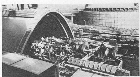
Bid 3. Turbine in Halbfreiluftaufstellung in Gyöngyös. Der Portalkran fährt über dem verschiebbaren Turbinenschutzdach. Unter dem Betonboden sind alle Anlagenteile im Gebäude untergebracht. Im Hintergrund befinden sich die Kühlelemente der Trockenkühltürme
