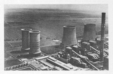
Bild 1. Gesamtansicht des 800-MW-Kraftwerkes Gagarin in Gyöngyös, Ungarn. In der linken unteren Ecke ist die Nasskühlanlage für den Block III. Die zwei zylindrischen Türme kühlen den Abdampf der Blöcke I und II. Die beiden grossen hyperbolischen Türme kühlen den Abdampf der Blöcke IV und V
