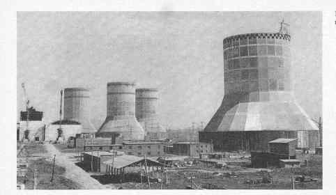
Bild 2. Trockenkühltürme bei Rasdan in Armenien (UdSSR)
