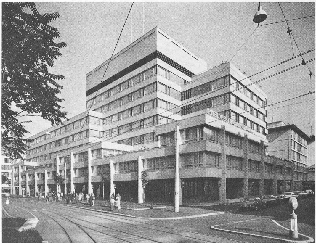
Der Neubau der Helvetia-Unfall am Bleicherweg in Zürich
