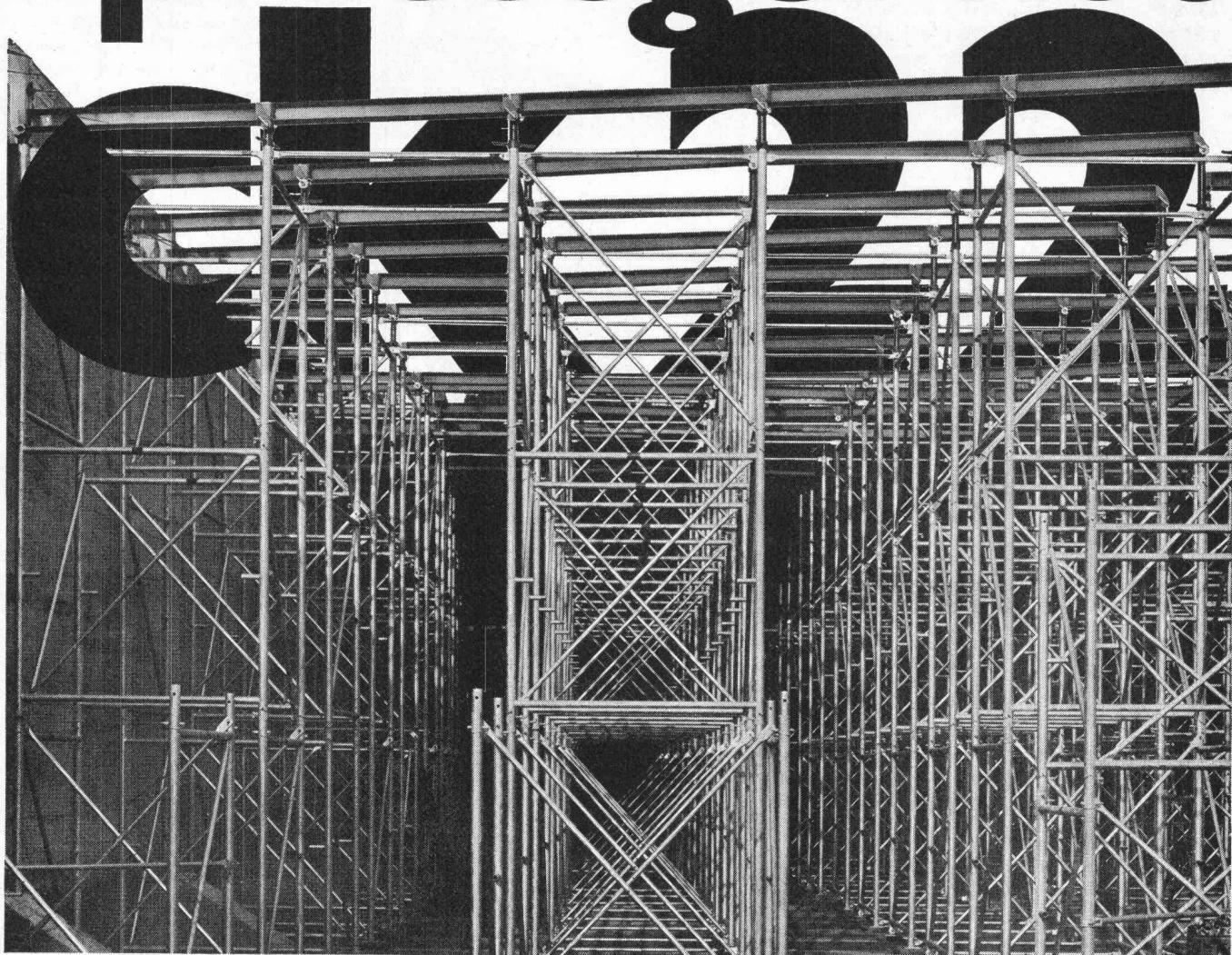
Das neue Spriessgerüst ck 22 dient zur Lastübertragung, insbesondere von Betonlasten. Das System besteht aus fachwerkartigen Rahmen, die seitensversetzt übereinander gestellt und mit Diagonalen zu einem Turm verbunden werden. Mit den schraubenlosen Verbindungen lassen sich sowohl Einzeltürme
