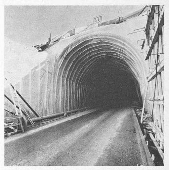
Bild 5. Tunnel Gleinalm-Nord (Österreich). Tunnelabdichtung mit Kunststoffdichtungsbahnen aus PVC auf Gunitunterlage. Stossverbindungen als Stehfalz mit Doppelnaht (druckluftgeprüft). Portalpartie
