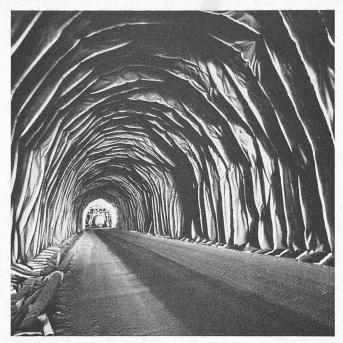
Bild 4. Tunnel Gleinalm-Nord (Österreich). Tunnelabdichtung mit Kunststoffdichtungsbahnen aus PVC auf Gunitunterlage. Stossverbindungen im Heizkeilschweissverfahren mit Doppelnaht ausgeführt (druckluftgeprüft)
