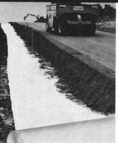
SODOCA-Vlies aus UV-stabilisiertem Polypropylen trennt, filtriert und verteilt die auf die Strasse wirkenden Kräfte im Unterbau. SODOCA verkauft Ihnen nicht irgendein Vlies, sondern für die verschiedensten Problemstellungen im Tiefbau jeweils spezielle Vliesstoffe: zum Beispiel für Strassenbau, Gleisbau, Baustrassen, Forstwege, Flugpisten, Drainage... Mit SODOCA sparen Sie Zeit. Und Zeit ist Geld. Denn mit SODOCA bauen Sie bei jeder Witterung: rationeller und schneller.
