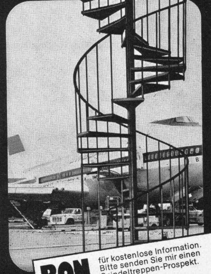
Nottreppe am neuen Fingerdock in Kloten
