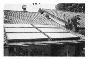
Anlage Erlenbach, 16  $\mathrm{m}^2$  Kollektor, 1500 l Speicher, für Gebrauchswarmwasser und Uebergangsheizung.
