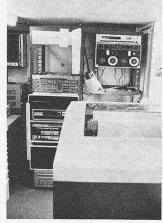
Solarimeter mit Schrittmotor zur Einstellung der Messposition (links). Innenansicht des Messwagens mit Bordcomputer und Zusatzgeräten (rechts)
