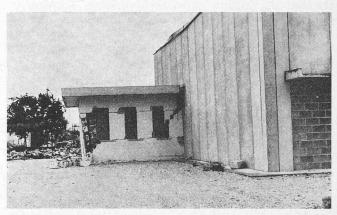
Bild 21. Vorfabrizierte Lagerhalle mit Backsteinanbau in Gemona. Tragskelett der Halle unbeschädigt. Steinwand bei Aufprall an steifen Anbau leicht eingedrückt. Dach des Anbaus durch die Impulsbelastung infolge ungenügender Fugenbreite abgeschert und weggeschoben
