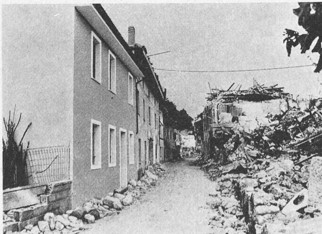
Bild 15. Rechts: Felssturz in oberflächlich angewittertem Gestein am Rand des Dorfes Braulins zwischen Gemona und Trasaghis. Im Vordergrund breite Risse in der auf einem Damm verlaufenden Strasse
