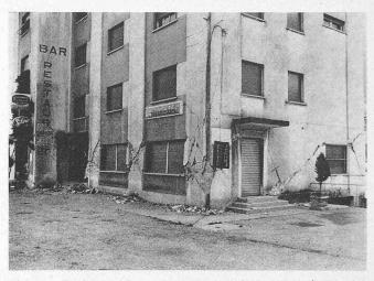
Bild 17. Fünfgeschossiges Hotelgebäude bei Venzone mit Wänden aus behauenen Natur- und Backsteinen. Beschädigung im Erdgeschoss durch typische X-Risse in den Fensterpfosten der Vorderfront und Diagonalriss auf der Stirnseite infolge inhomogenen Fundationsverhältnissen
