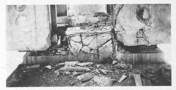
Bild 23. Autobahnbrücke mit 32 Feldern über den Tagliamento. Auflager der vorfabrizierten Träger auf massiven Pfeilerscheiben. Betonabplatzungen an den Trägern und vollständig zerstörte Auflagerkonsole infolge Anpralls des durch das Beben beschleunigten Trägers. Linker Brückenträger vom Auflager abgerutscht
