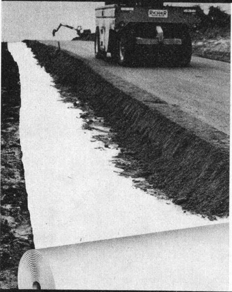
SODOCA-Vlies aus UV-stabilisiertem Polypropylen trennt, filtriert und verteilt die auf die Strasse wirkenden Kräfte im Unterbau. SODOCA verkauft Ihnen nicht irgendein Vlies, sondern für die verschiedensten Problemstellungen im Tiefbau jeweils spezielle Vliesstoffe: zum Beispiel für Strassenbau, Gleisbau, Baustrassen, Forstwege, Flugpisten, Drainage... Mit SODOCA sparen Sie Zeit. Und Zeit ist Geld. Denn mit SODOCA bauen Sie bei jeder Witterung: rationeller und schneller.
