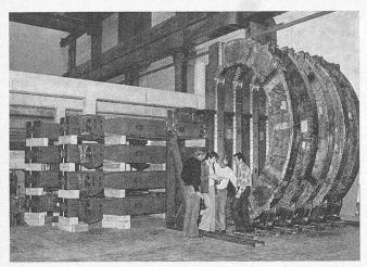
Die ersten Teile des Tokamak-Experimentes ASDEX liegen im Max Planck-Institut für Plasmaphysik in Garching zum Zusammenbau bereit. Rechts sieht man die ersten fünf der D-förmigen Hauptfeldspulen, links Teile des 100 Tonnen schweren Gerüstes
