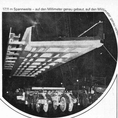
Koblenz: eine Strasse wurde breiter - eine Brücke drüber länger. In der Werkstatt haben wir sie millimetergenau fertiggestellt: eine SBB-Brücke von immerhin 50 Tonnen Gewicht in einem Stück zusammengeschweisst.
