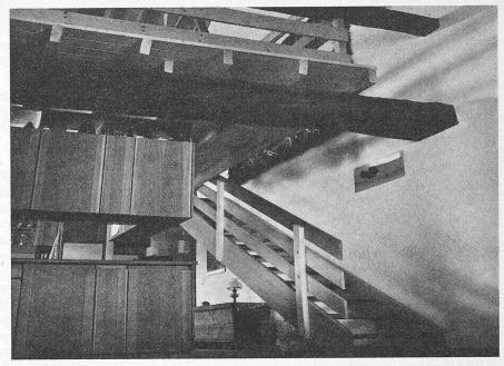
Bild 16 und 17. Leider hat nicht jedes umzubauende Haus einen intakten Dachstuhl. Da die Bemessung früher meist grosszügig erfolgte, bleibt eine statische Reserve, die einige Beschädigungen überbrücken kann (links). Muss ein Dachstuhl ersetzt werden, dann lassen sich alt und neu ohne Angleichung kombinieren, ohne dass sie sich gegenseitig weh tun
