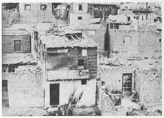
Bild 4. Allmähliche Verbesserung der baulichen Substanz einer Squattersiedlung in Südamerika durch die Verwendung dauerhafter Materialien (Backstein usw.)
