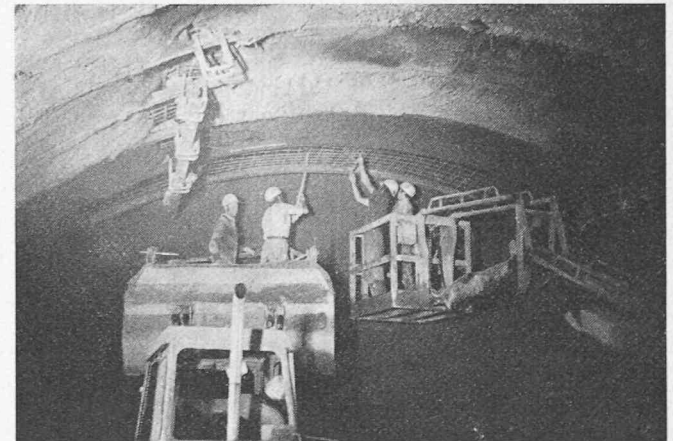
Bild 3. Verlegen der Baustahlgewebematten und Einbau des Streckenbogens im Bereich der Firste beim Bau des Autobahntunnels Regensburg-Pfaffenstein
