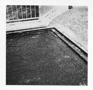
Brückenplattenisolierungen mit Bitumen-Kautschuk-Dichtungsbahnen zur Aufnahme von bituminösen Misch- und Gussasphaltbelägen.
