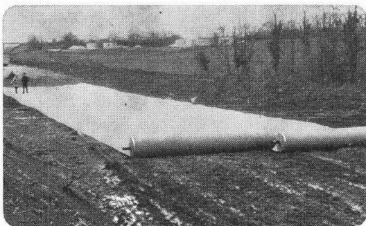
Abrollen der Matte, Vorkopf- aufschüttung
