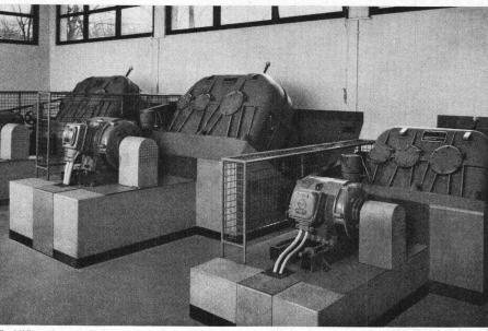
Für Kläranlagen, Zahnradgetriebe für leistungsfähige Schneckenpumpen, Rührwerke in Belüftungsbecken, Schlamm-Rundräumer, Rechen-Reinigungsmaschinen (ARA Olten).
