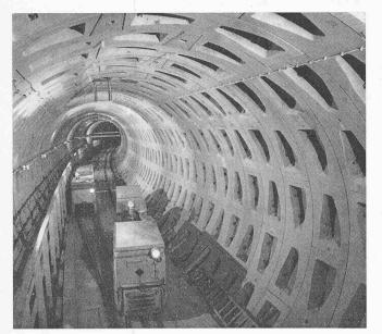
Bild 1 (links). Streckentunnel von Bild 2 im Bauzustand. Einschaliger Tunnelausbau mit Stahlbetontübbings
