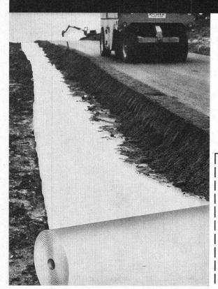
SODOCA-Vlies aus UV-stabilisiertem Polypropylen trennt, filtriert und verteilt die auf die Strasse wirkenden Kräfte im Unterbau.
