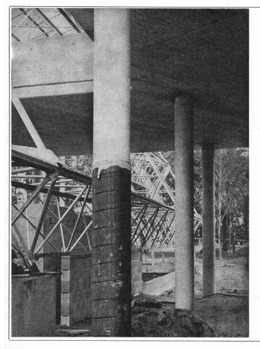
Aussparungsrohre für Hohlkörperdecken
