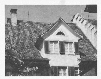
Bild 1. Beispiel einer Verformung Tunter Langzeitbeanspruchung: Durchhängender First an einem alten Haus in Grüningen (Kt. Zürich)
