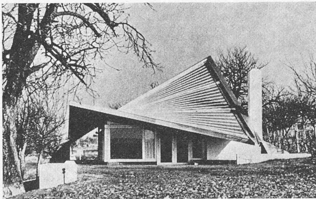
Bild 7. Einfamilienhaus in Hegenheim, Elsass (1961), [11]. Dach als hyperbolische Paraboloidschale aus drei je 15 mm dicken Brettlagen, die kreuzweise aufeinandergeleimt wurden. Pressdruck für die Verleimung mittels Verschraubung. Entwurf: Gutmann+Schwarz, Zürich. Berechnung und Durchführung der Modellversuche: Ing. Hossdorf, Basel
