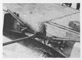
Bild 12. Hängeschale in Dortmund (1969) [9]. Teile der Randträger mittels Keilzinkungen über die gesamte Trägerbreite gestossen; Montageverleimung. Das Bild zeigt die Einrichtung zur Erzeugung des notwendigen Pressdruckes in Längsrichtung
