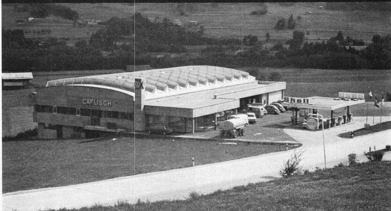
Garage CAFLISCH IN ILANZ, Graubünden. Architekturbüro Fetz AG in Ilanz. Spenglerei Jöhrimann, Bonaduz. Sämtliche Spenglerarbeiten, Flachdach- und Shedeinfassungen, Dachrinnen und Ablaufrohre aus RHEINZINK.
