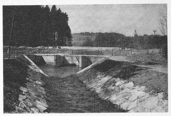
Bild 6. Unterwasserseite des Pumpwerks Werd (Schöpfleistung 8,5 m³/sec). Mit dem System der Unterwasserhorizontalpumpen konnte auch eine befriedigende Integration in die Landschaft gefunden werden
