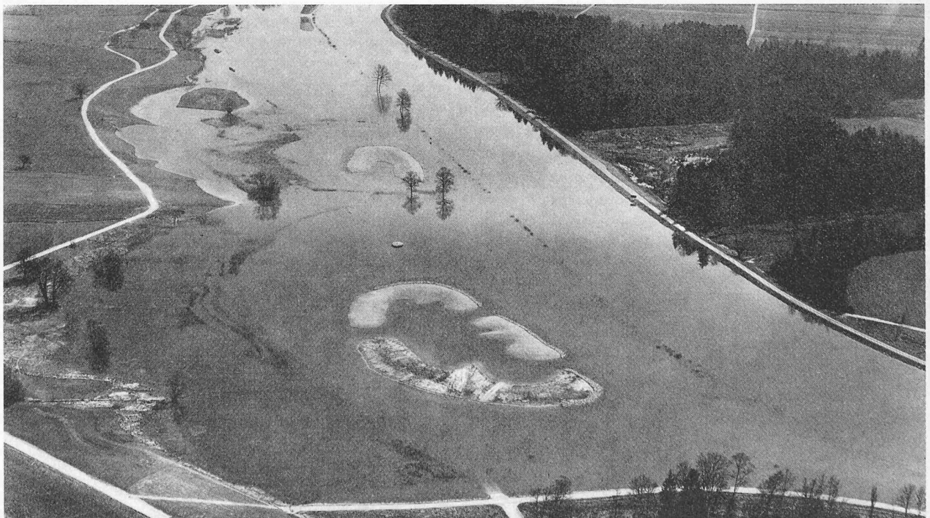
Bild 1. Der neugeschaffene Flachsee Unterlunkhofen. Er wurde durch den Kraftwerkstau ermöglicht und nach den Erfordernissen einer international gefährdeten Wasservogelfauna als Brut-, Rast- und Überwinterungsplatz gestaltet (Flugaufnahme Comet)
