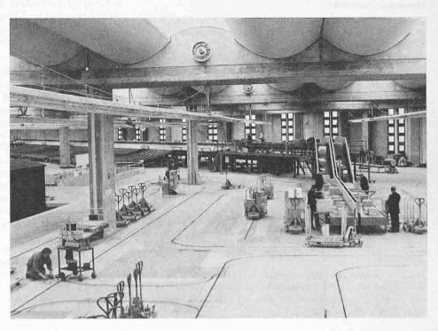
Blick in den hinteren Abschnitt der 24 600 m<sup>2</sup> grossen Schnellguthalle der SBB in Zürich-Altstetten, in die u.a. sieben Gleisanschlüsse münden. Im Hintergrund sieht man die Sortieranlage, im Vordergrund automatisch gesteuerte und durch eine Unterflur-Kettenanlage in Bewegung gesetzte Hubstapler
