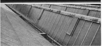
Kittlose Industrieverglasung von Tuchschmid als Shed- oder Satteloberlicht, Fassadenlichtband oder Vordach.
