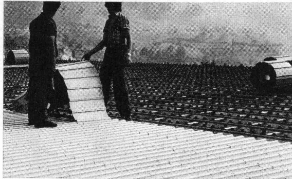
Spinnerei Ibach SZ: 1630 m 2 dipl. Arch. ETH/SIA Schindler & Schindler, Zürich
