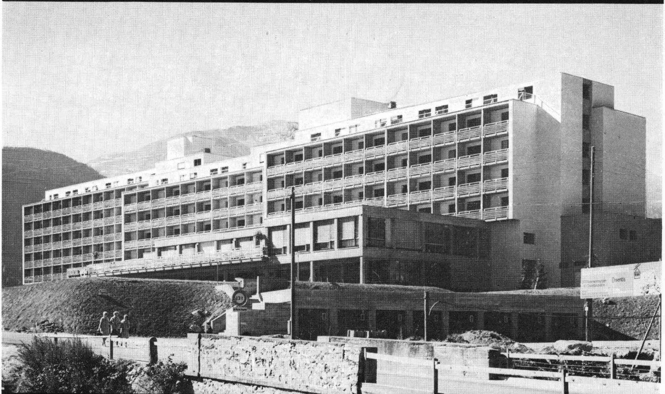
Hotel ACLA DE FUNTAUNA IN DISENTIS. Architekturbüro Mathis in Chur. Spenglerei Candidas in Rabus. Sämtliche Flachdacheinfassungen und Wandanschlüsse aus RHEINZINK.
